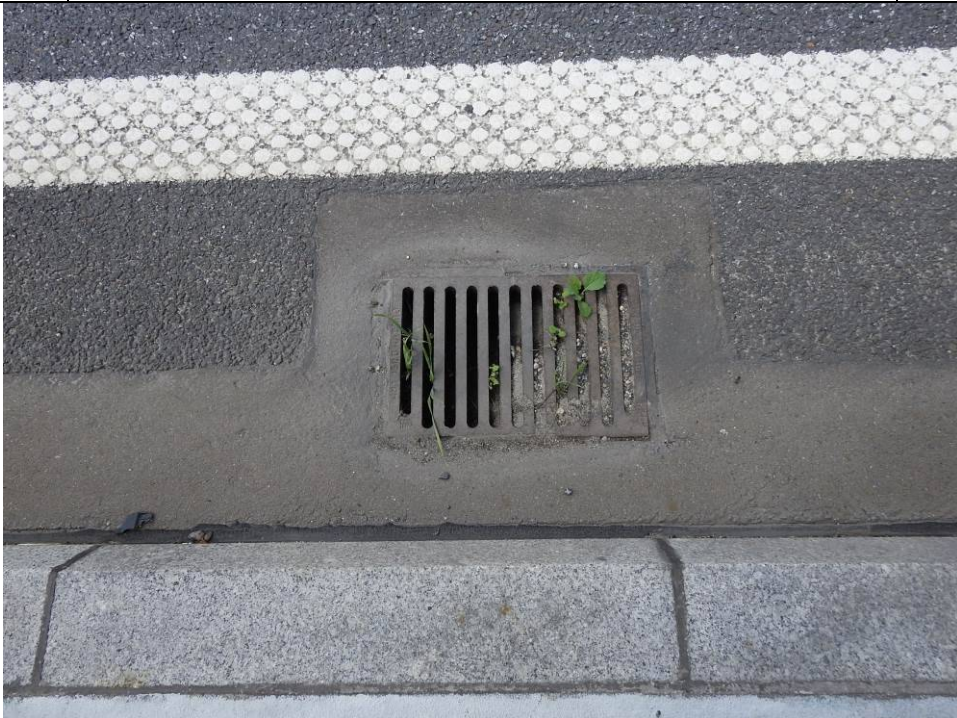
Fot. 31 Zanieczyszczenie wpustu mostowego.
