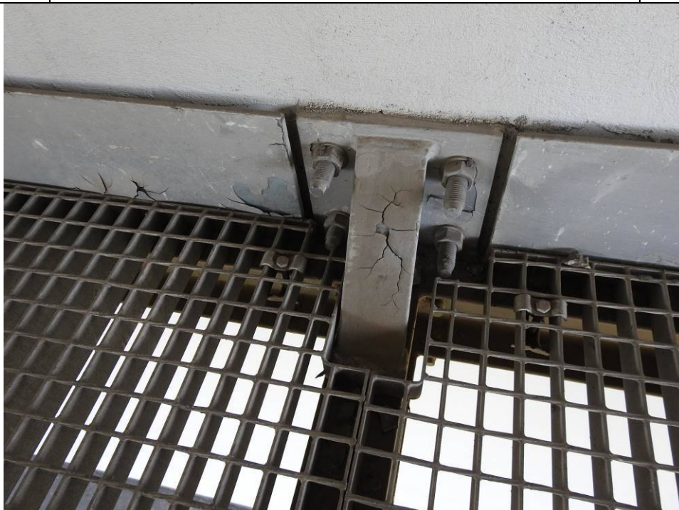
Fot. 33 Złuszczenia powłok malarskich konstrukcji wsporczej na podporze pośredniej. Uszkodzenie występuje na większości pomostów roboczych.
