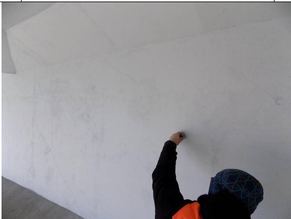
Fot. 5 Widok na pomiar rys ukośnych na przeponie.
