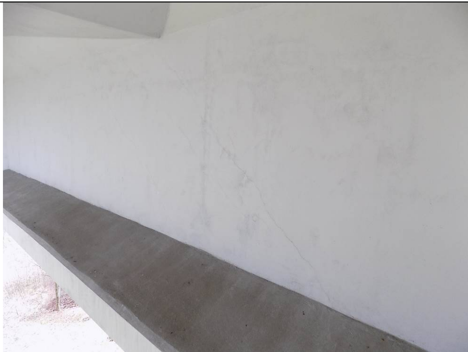
Fot. 6 Widok na rysę ukośną na przeponie. Rysa 0,3 mm.
