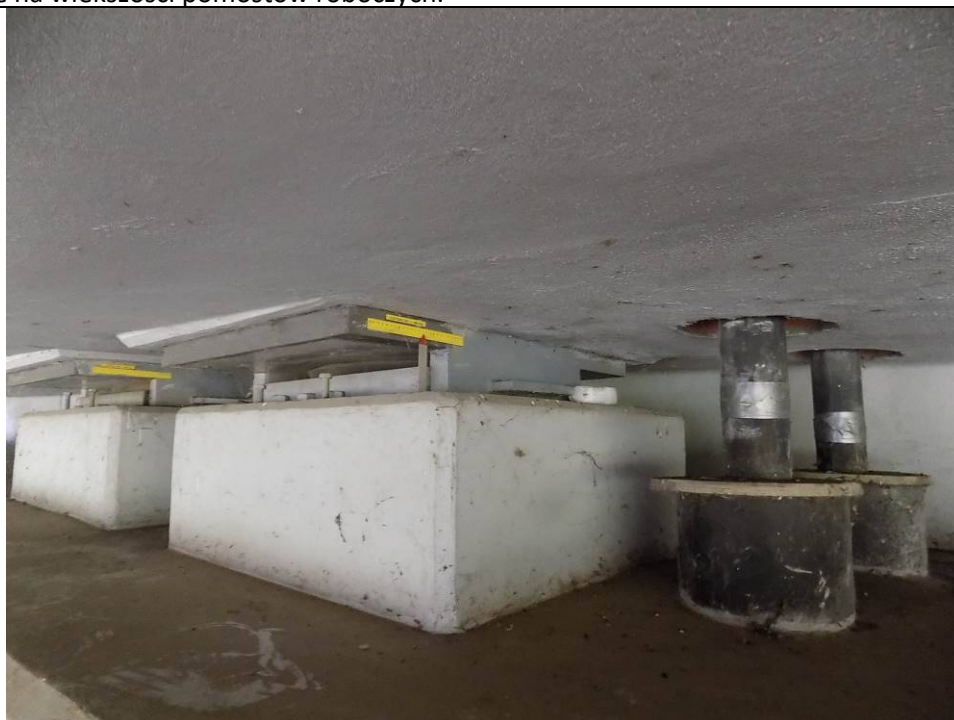
Fot. 34 Widok na łożysko nr 3. Wysunięcie się warstwy teflonu z łożyska ułożonego pomiędzy prowadnicą boczną a płytą dolną łożyska.
