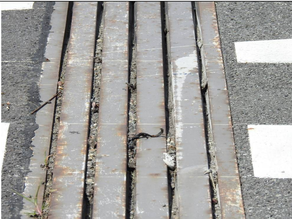
Fot. 32 Zanieczyszczenie dylatacji od strony Ostrawy. Korozja elementów stalowych dylatacji.
