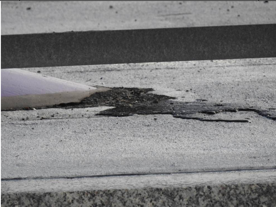
Fot. 25 Wyływy masy bitumicznej w rejonie przejścia wanty przez kapę chodnikową.
