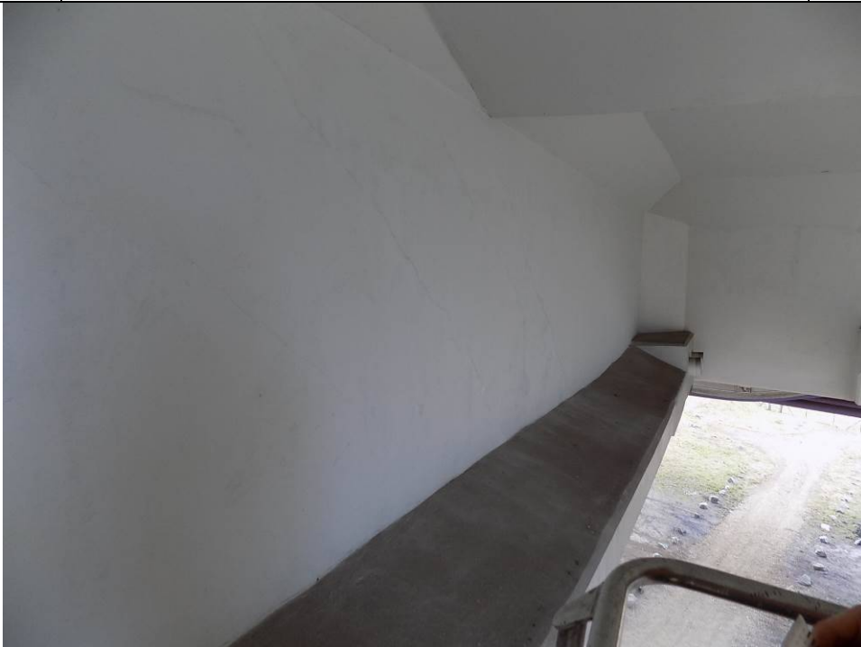
Fot. 1 Widok na przeponę pomiędzy obiektem głównym a estakadą. Widoczne rysy ukośne na przeponie.
