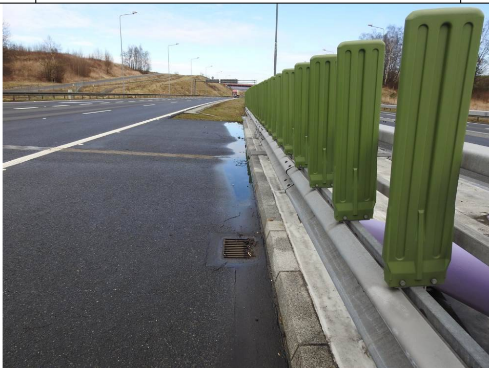
Fot. 29 Widok w kierunku Gliwic. Nitka w kierunku Ostrawy. Widoczne zastoiska wody w rejonie dylatacji.
