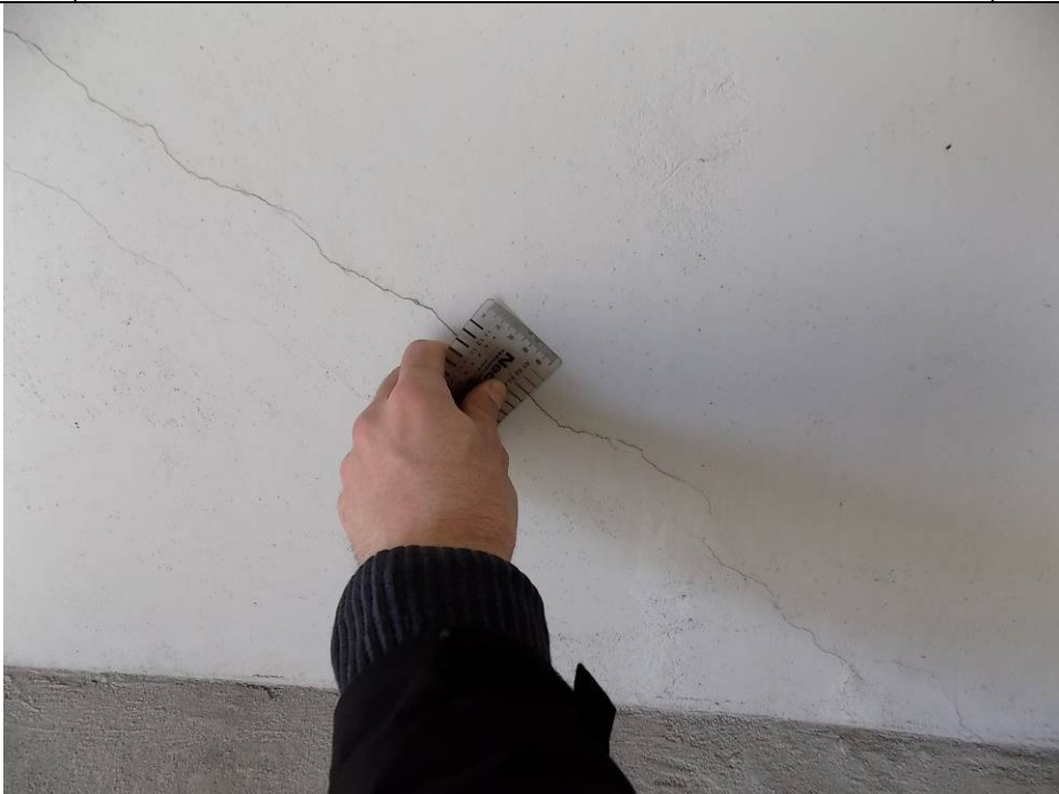
Fot. 7 Pomiar rysy ukosnej na przeponie 0,3 mm.
