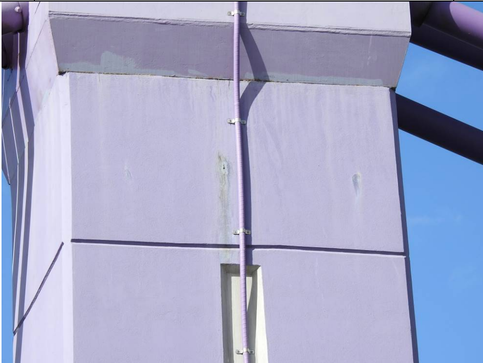
Fot. 21 Widok na pylon. Zacieki i wykwyty na pylonie.
