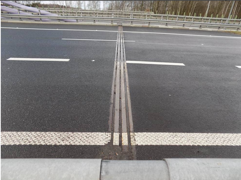
Fot. 17 Widok na dylatację modułową na przyczółku od strony Gliwic. Widoczne zanieczyszczenia dylatacji, ogniska korozji.
