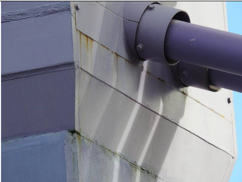
Fot. 26 Widok na pylon w rejonie podłączenia want. Rdzaw zacieki.
