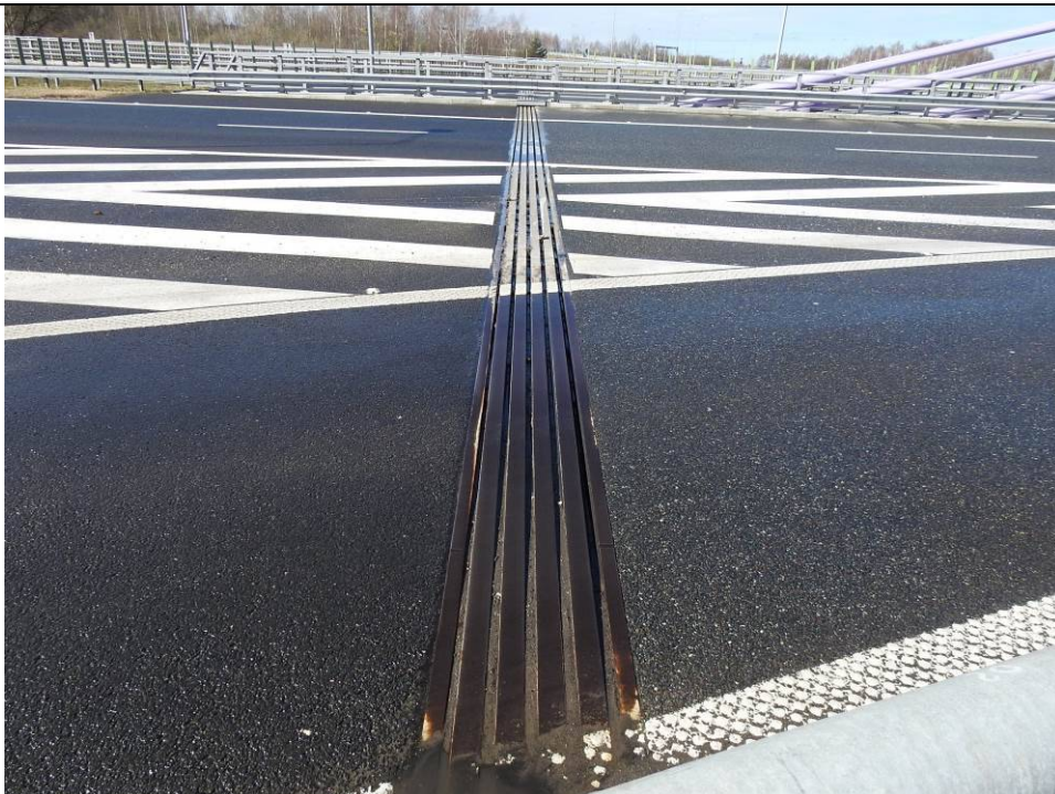
Fot. 22 Widok na dylatację na przyczółku od strony Ostrawy. Nitka w kierunku Gliwic. Widoczne zanieczyszczenia dylatacji. Korozja elementów stalowych.
