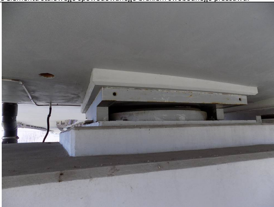
Fot. 16 Widok na łożysko. Widoczne drobne ogniska korozji stali. Zjawisko występujące na każdym łożysku.
