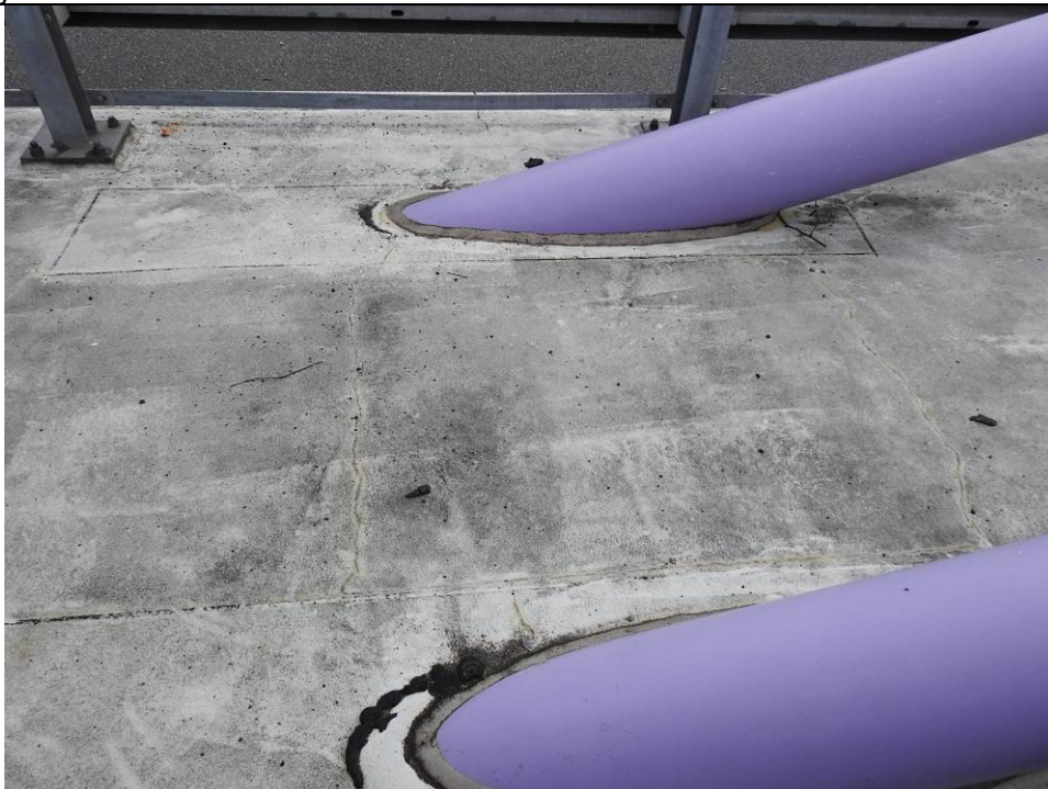
Fot. 28 Widok na kape chodnikową w rejonie podłączenia want. Widoczne zarysowania kapy.
